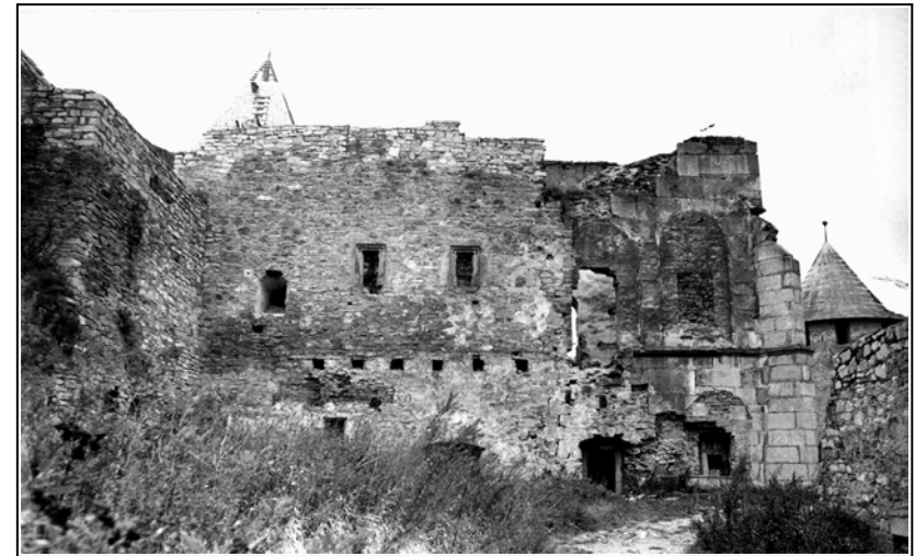
Рис. 3. Північний фасад Замкової церкви з замуrowаними прорізами відкритої галереї паперті (фото 1986 року)
