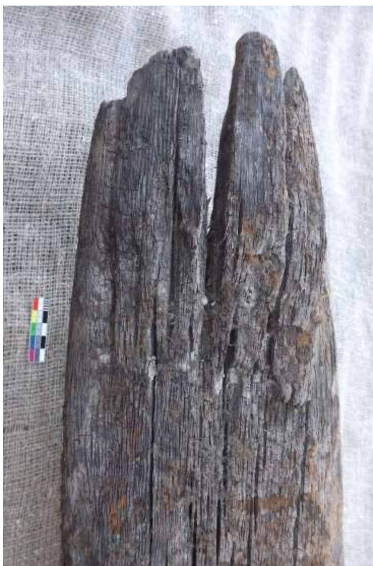
Рис. 7. Пошкодження нижньої частини балки
