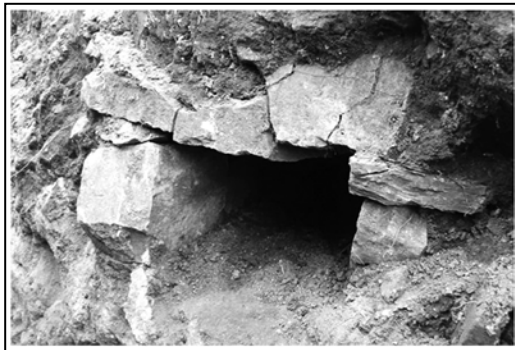
Рис. 6. Інженерні комунікації на території Нової фортеці (фрагменти водопроводу та каналізації)
